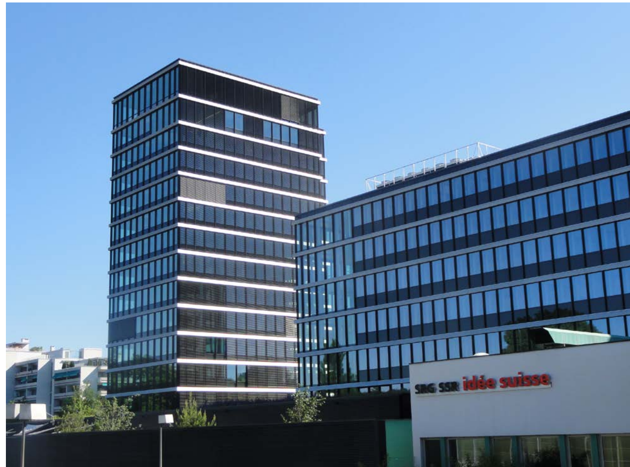
Gesamtansicht nach Abschluss der Bauarbeiten
