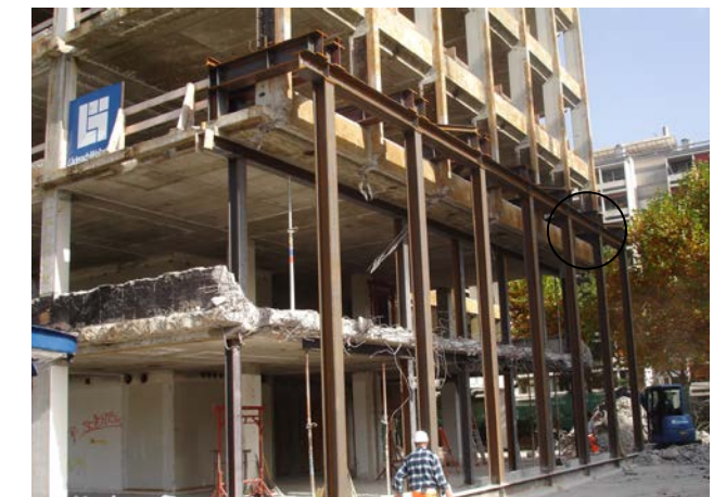
Provisorische Absperrung G3 - Anpassungen Sockelgeschoss
