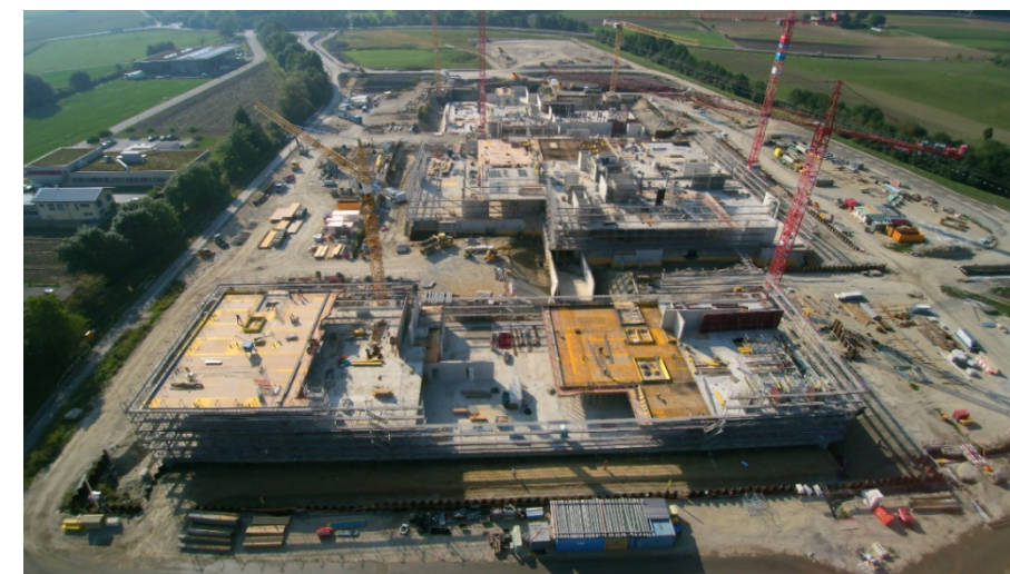
Rohbau, Stand Februar 2017 / CSL
