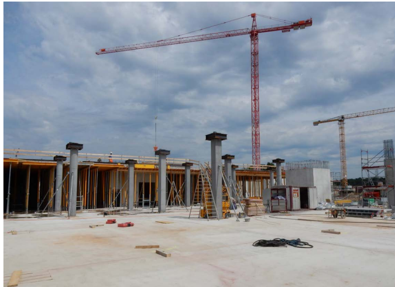
Betonstützen, Stand Januar 2017 / CSL
