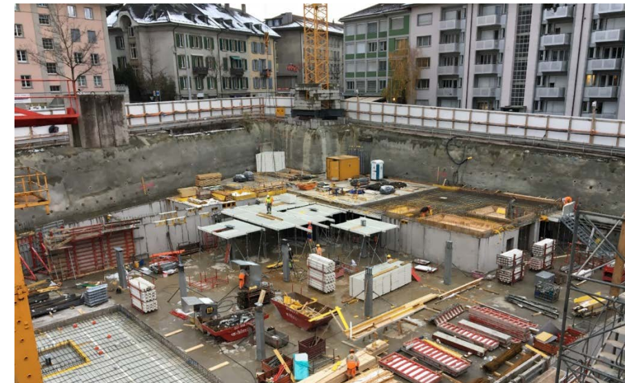
Rohbau 2. Untergeschoss, Stand Dezember 2017 / smt
