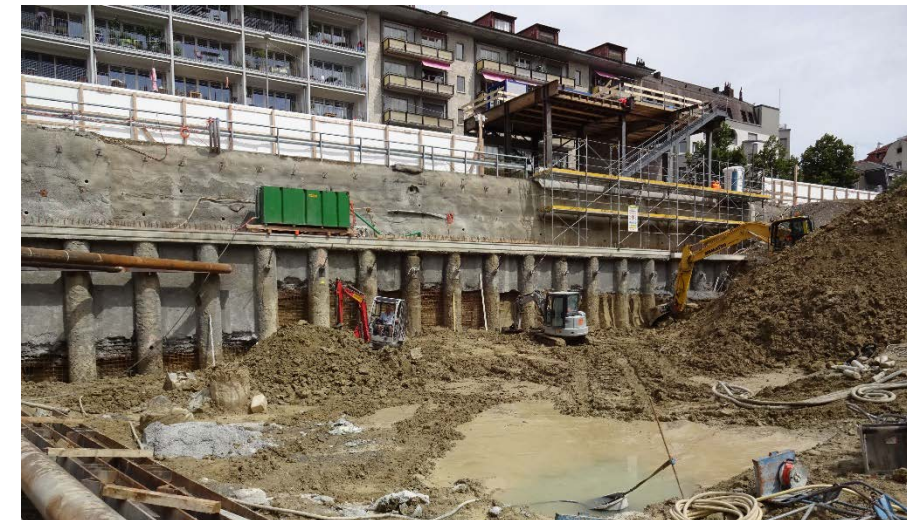
Baugrube Stand Juli 2017 / smt
