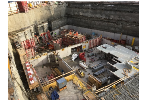
Rohbau Stand Dezember 2017 / smt
