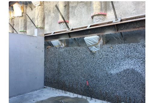
Schnittstelle Baugrube / Rohbau / smt
