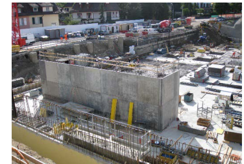
Rohbau 2.UG / smt
