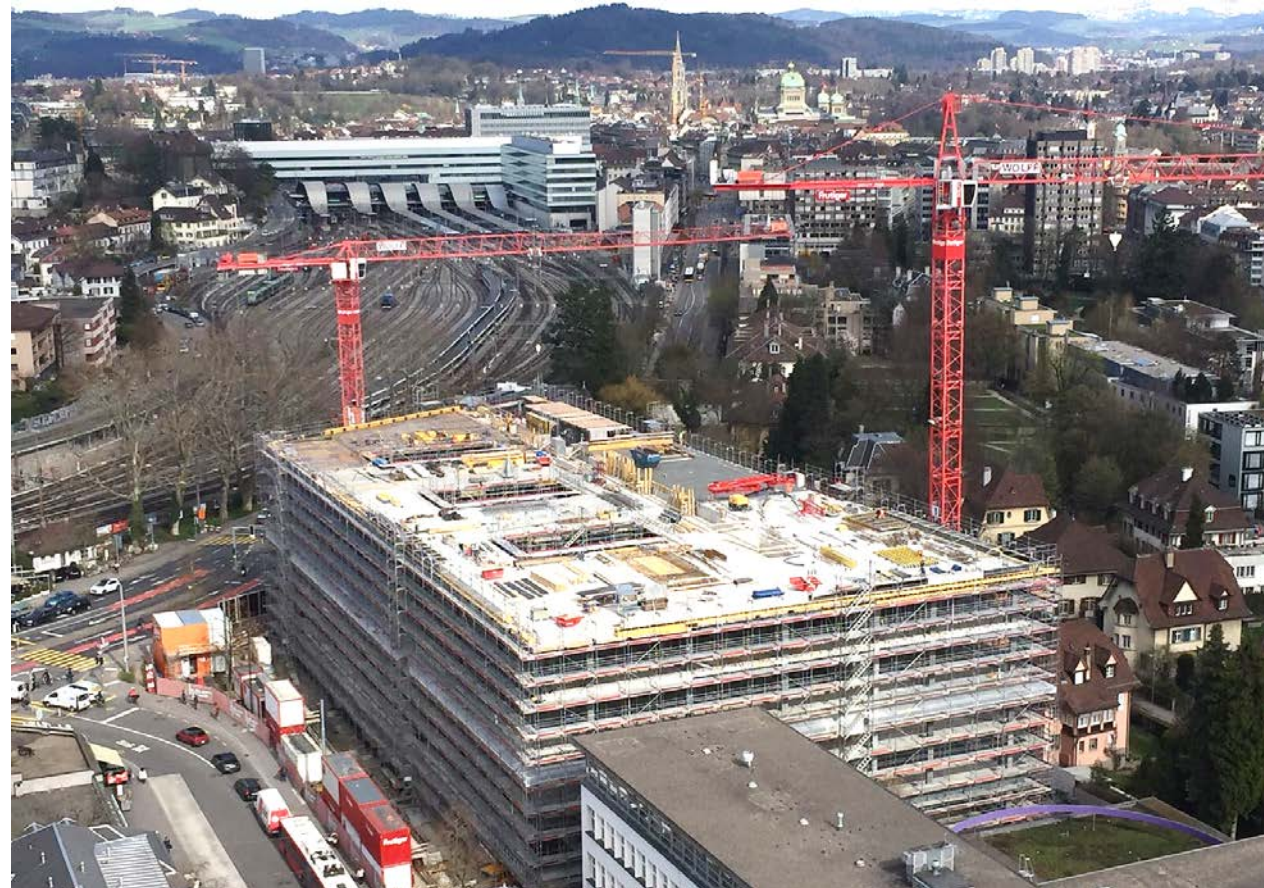
Rohbau 2. Untergeschoss, Stand August 2017 / smt
