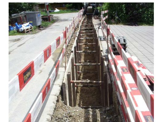
Weitere Etappe bereit für den Rohrleitungsbau
