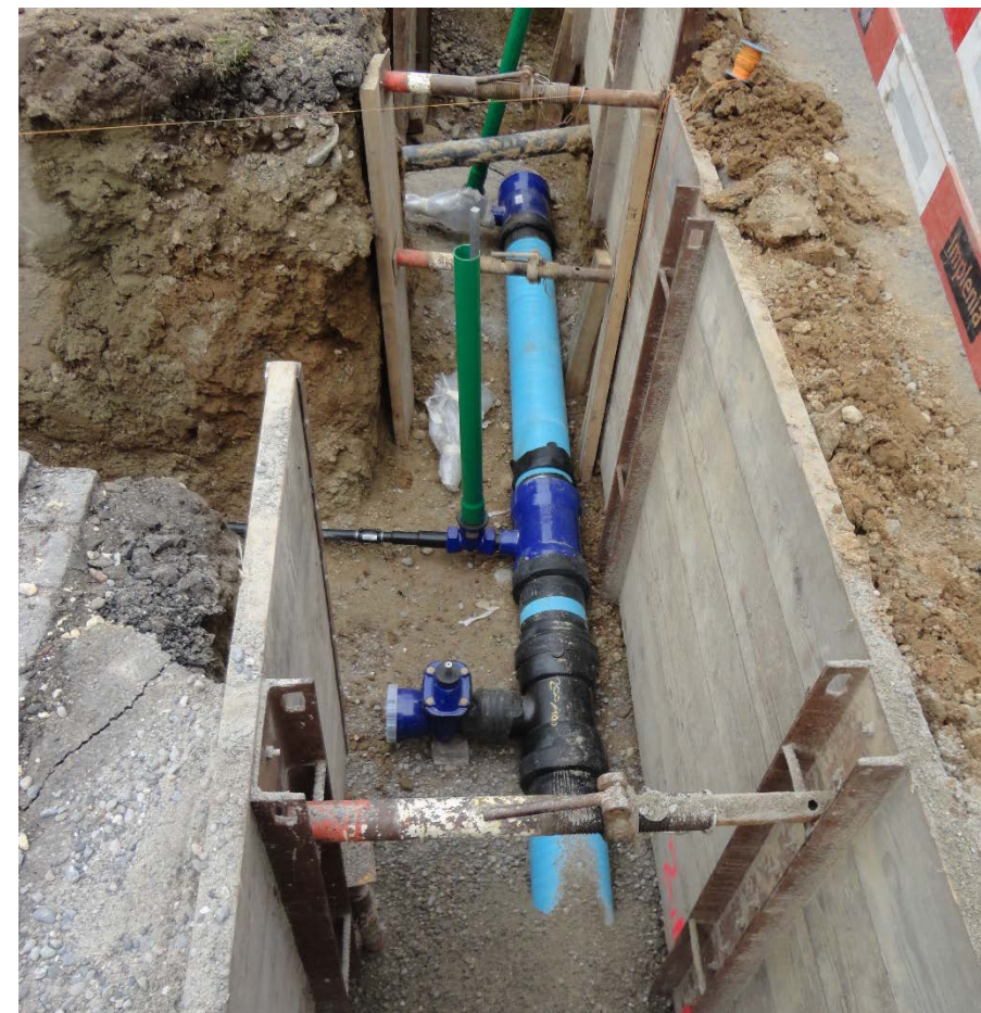
Rohrleitungsbau im konventionellen Graben
