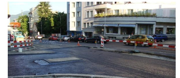
Unterführungs-/ Aarauerstrasse, Stand August 2008
