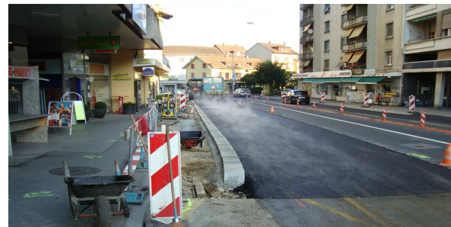
Unterführungs-/ Aarauerstrasse, Stand August 2008
