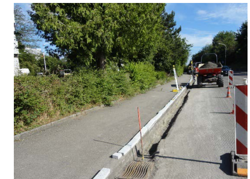
Vorarbeiten unter Verkehr
