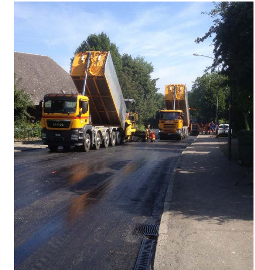
Einbau Deckbelag; Bitumenanstrich aufgetragen
