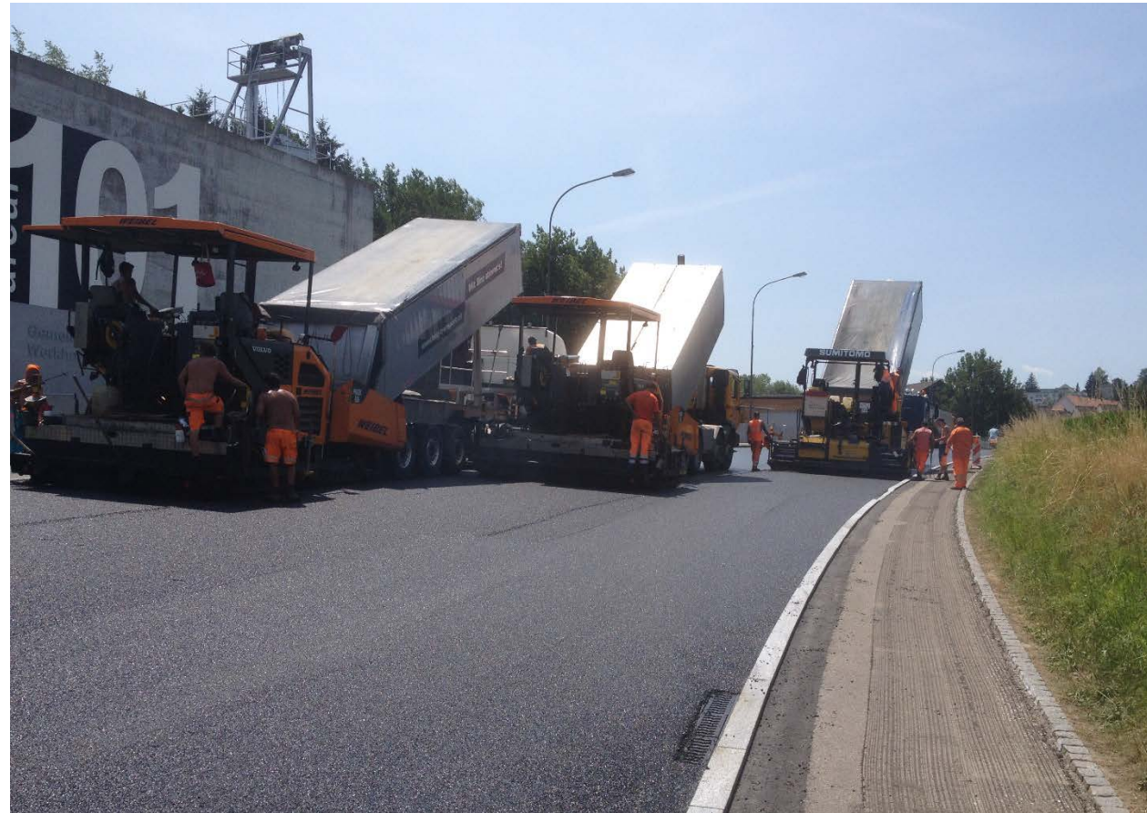
Einbau Deckbelag mit drei Einbaufertiger
