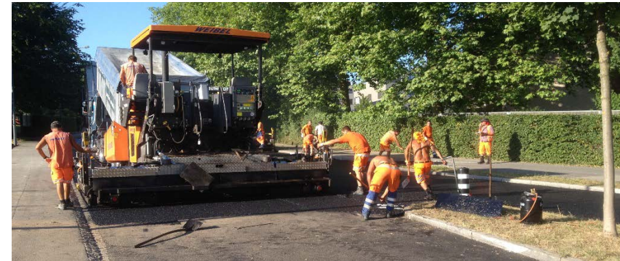
Einbau Trag- und Binderschicht
