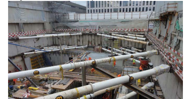
Rohbauarbeiten Decke U3 N2 Nov.2018 / smt
