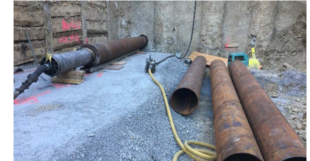
Schlagvortrieb Anschluss SL Wankdorfstrasse GBZ Aug. 18 / smt
