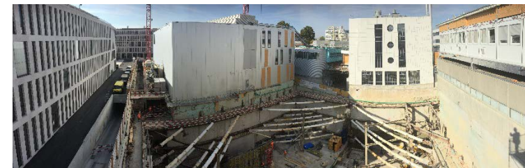
Blick in Baugrube Stand Okt. 2018 / smt
